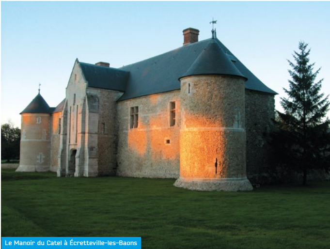
Le Manoir du Catel à Écretteville-les-Baons
