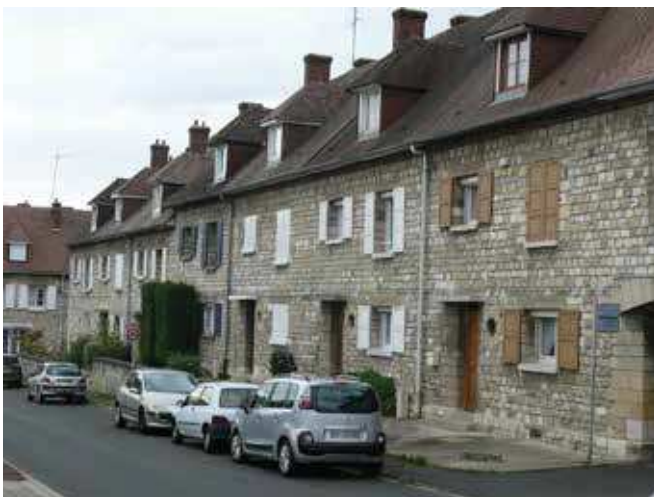
Place de Verdun, Sotteville-lès-Rouen - Place de Verdun ©CAUE76
