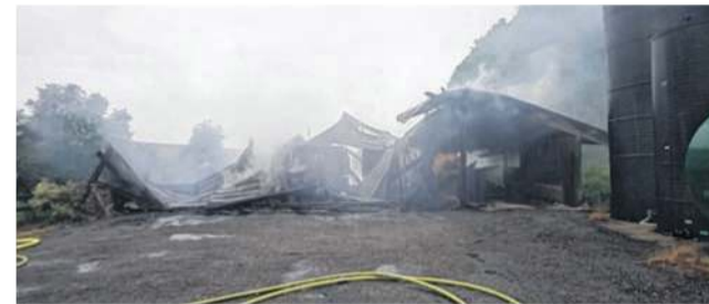
Le hangar de 600 m 2 a été détruit dans l'incendie.
